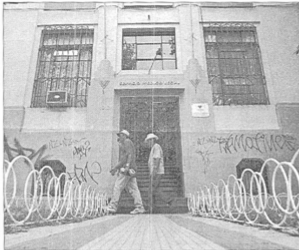
El actual edificio que alberga las instalaciones del SML fue construido en 1920. A juicio de los especialistas ya es tiempo que Chile se rija por los cánones de la medicina internacional en materia de infraestructura. Foto: Ricardo González
